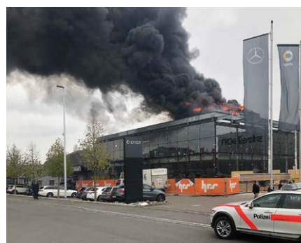
20.11.2019, Kreuzlingen Garagewerkstatt / Gewerbegebäude Schweissen
